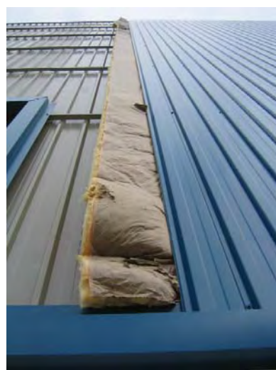
Cerramiento de Fachada (Sándwich).
