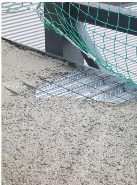
Image 1. Bétonnage du plancher collaborant INCO 70.4
